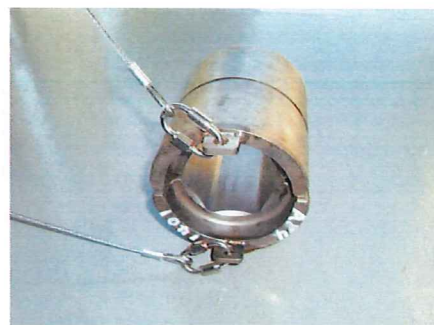
200 t 落下防止ワイヤー取付状況
